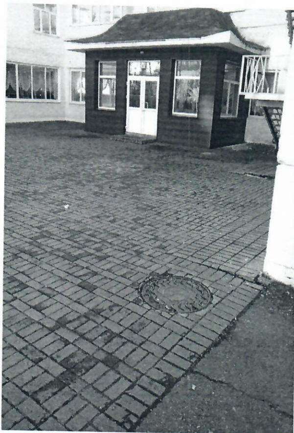
фото 8. ВШ. Входная площадка (перед дверью)
