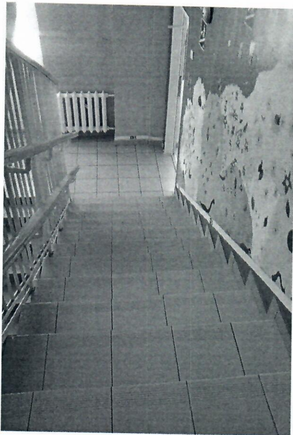
фото 16. ВШ. лестница (внутри здания)
