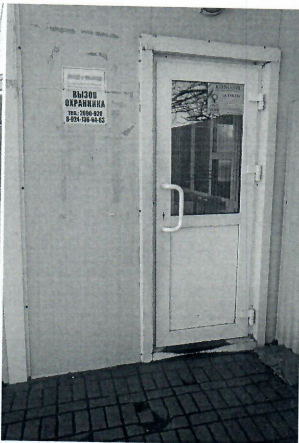
Фото 2. ВШ. Вход на территорию через пост охраны
