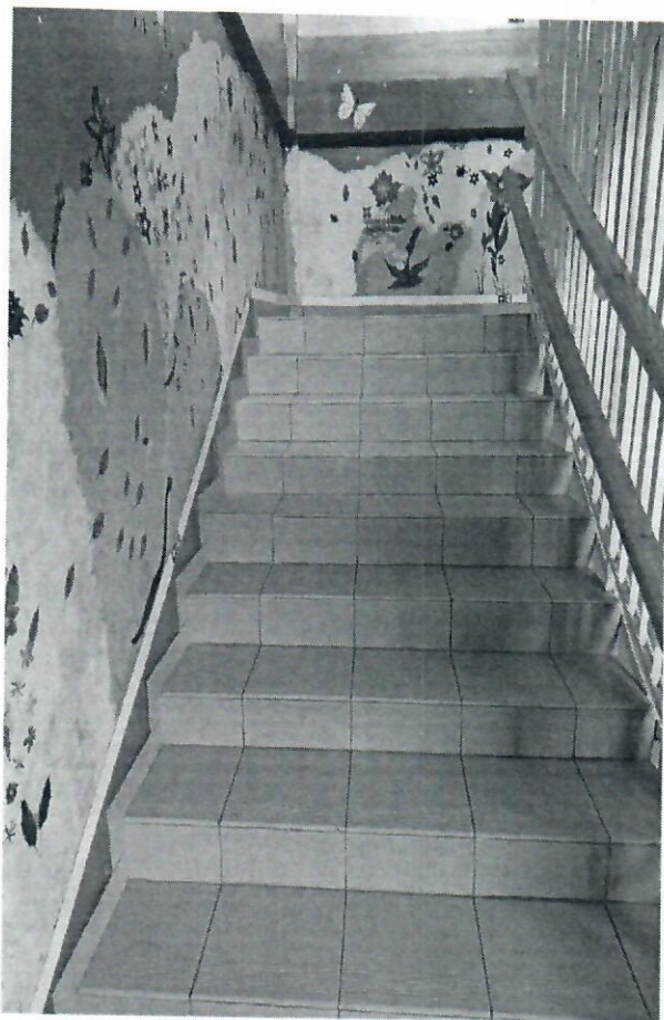
фото 20. ВШ. Пути эвакуации
