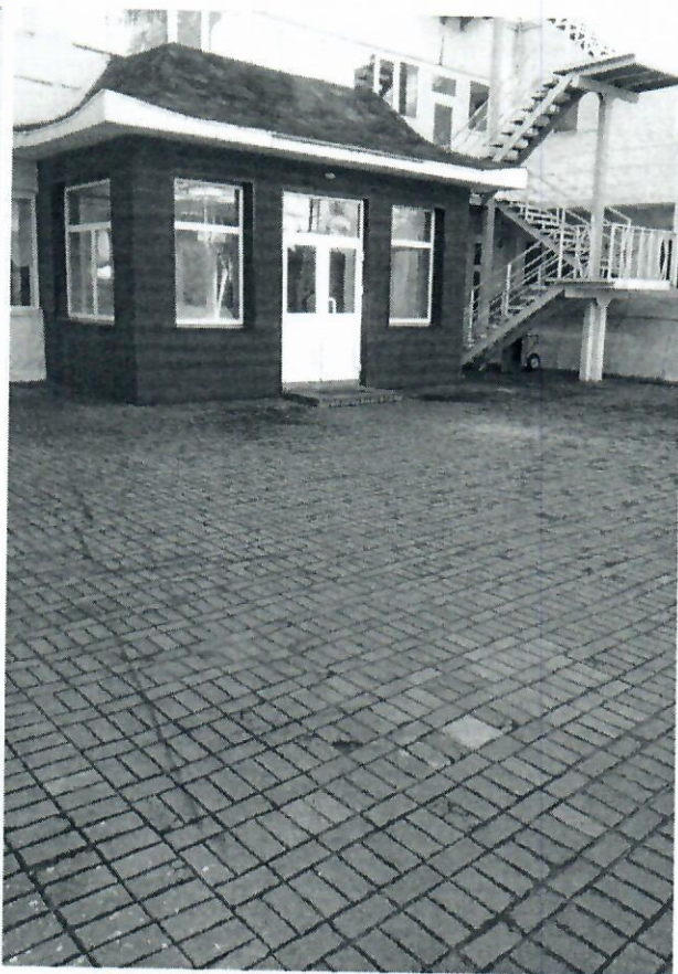
Фото 9. ВШ. Входная площадка (перед дверью)
